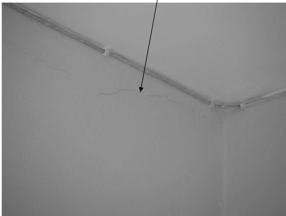
TRHLINA POD STROPNÍ KONSTRUKCÍ
