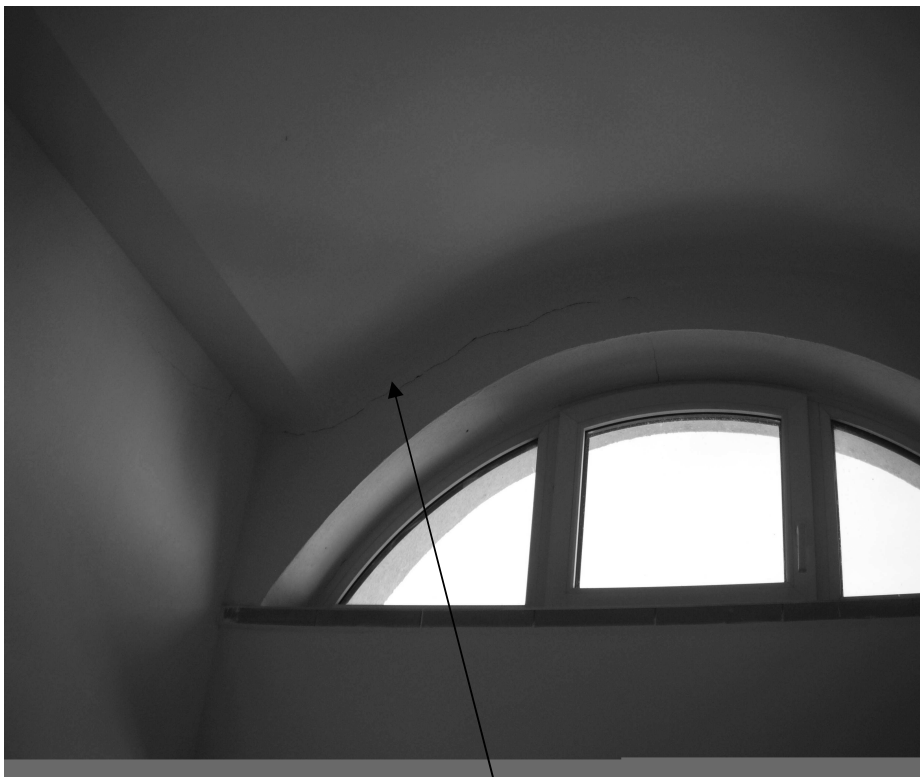
TRHLINA POD STROPNÍ KONSTRUKCÍ
