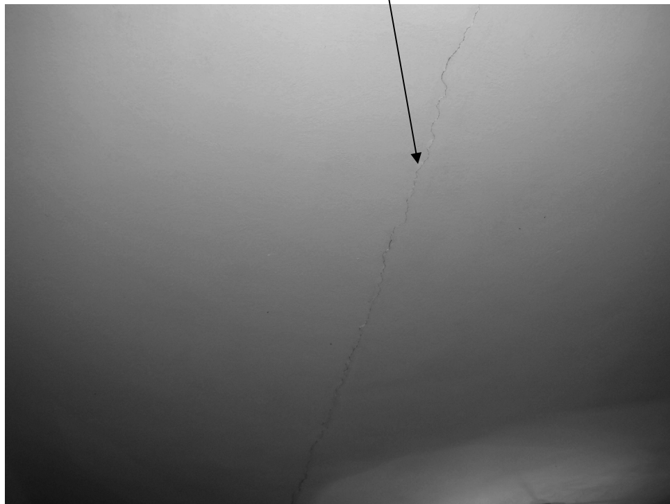
—TRHLINA MEZI STROPNÍMI PANELY
