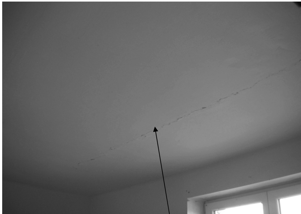
—TRHLINA MEZI STROPNÍMI PANELY
