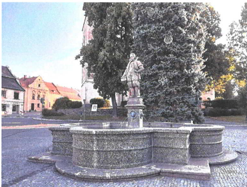
Stav po obnově
