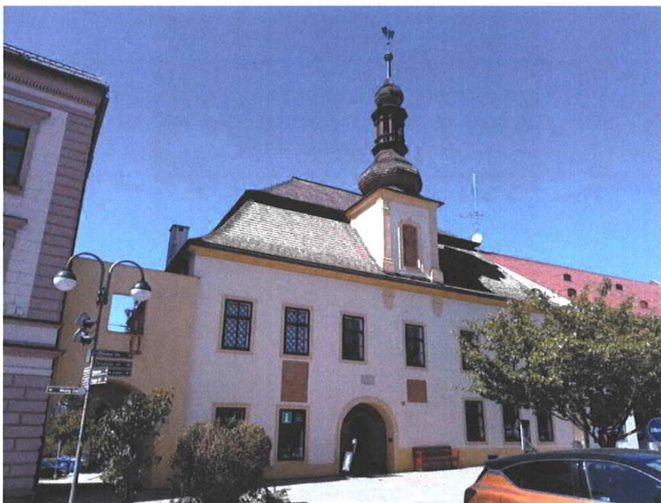
Stav po obnově
