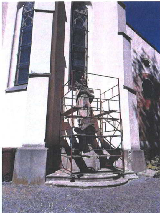
Stav před obnovou
