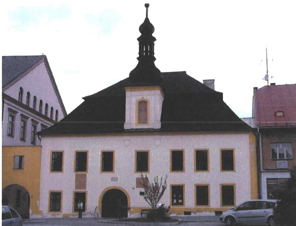
Stav před obnovou
