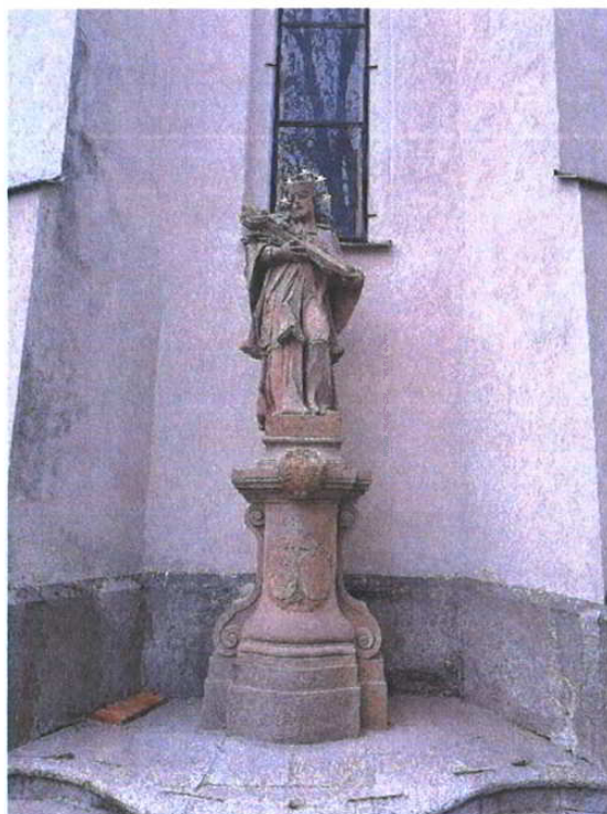
Stav po obnově
