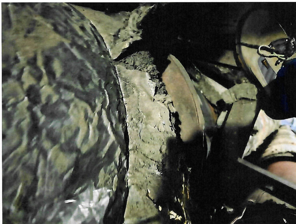
Obr. č. 26 až 27: Místo napojení spodního a horního dílu komína, respektive průduchů.
